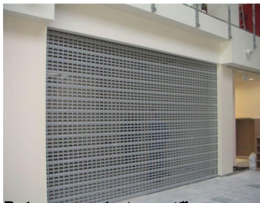
Рис. 1. Роллетная решетка на фасаде здания
