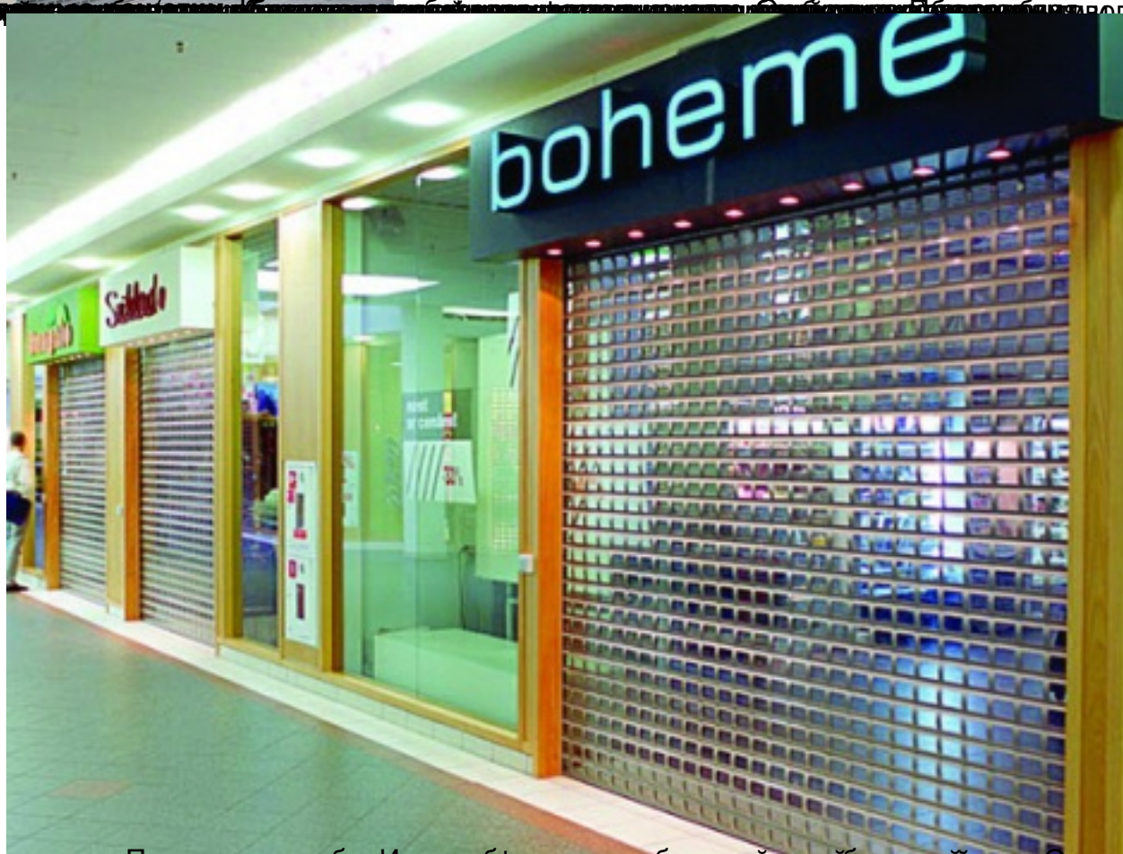
Рис. 1. Роллетная решетка на фасаде здания
